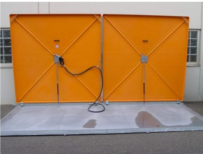
Abbildung 1: Abfüllplatz komplett montiert
